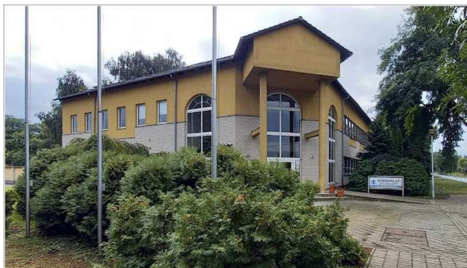
Fotó: Nyírségvíz Nyíregyháza és Térsége Víz- és Csatornamű Zrt. épülete (www.google.com)
