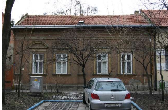
37. Deák Ferenc utca 9. 6267 Lakóház
